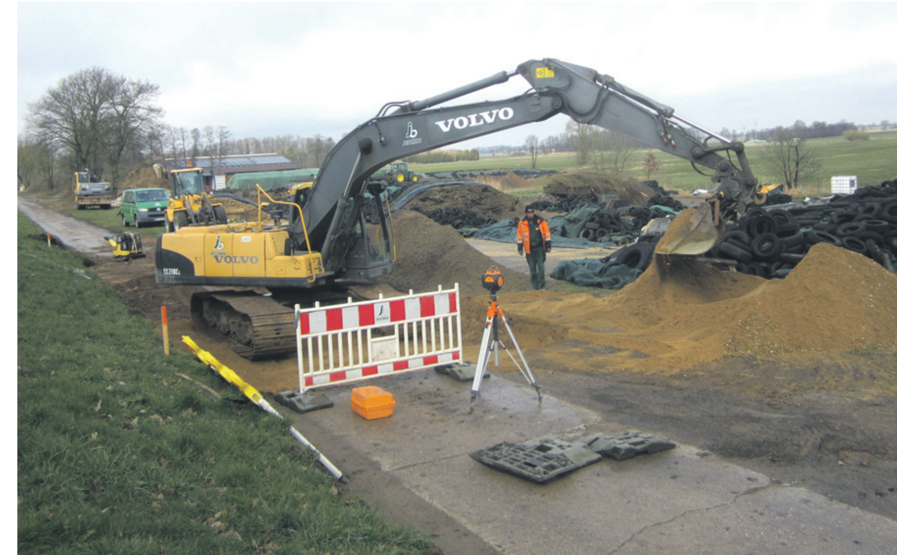
Stelle packt Ausbau der Straße Achterdeich an: Zunächst wurden am Achterdeich Probefelder freigelegt, um die Beschaffenheit des Untergrundes festzustellen. Foto: wa
